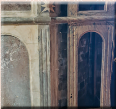
ภาพที่ ๒๕ ฐานชุกชีหินอ่อนและฐานไม้ระบายสี ลายหินอ่อนที่ต่อเติม เพื่อประดิษฐานพระพุทธรูปปฏิมา
